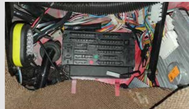
Den gamla säkringsboxen från kupésidan precis innan den monteras loss från torpedväggen.
